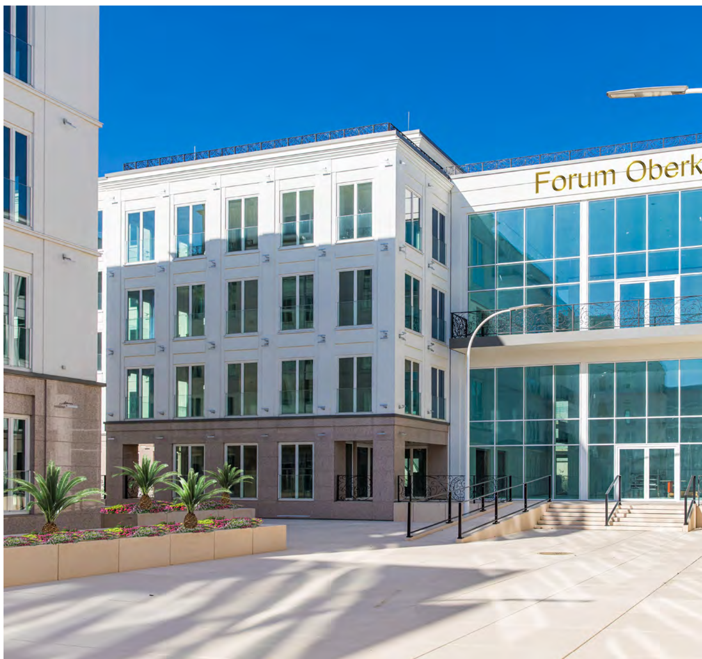
Blick auf den Innenhof mit Palais Mona und Forum Limperich
