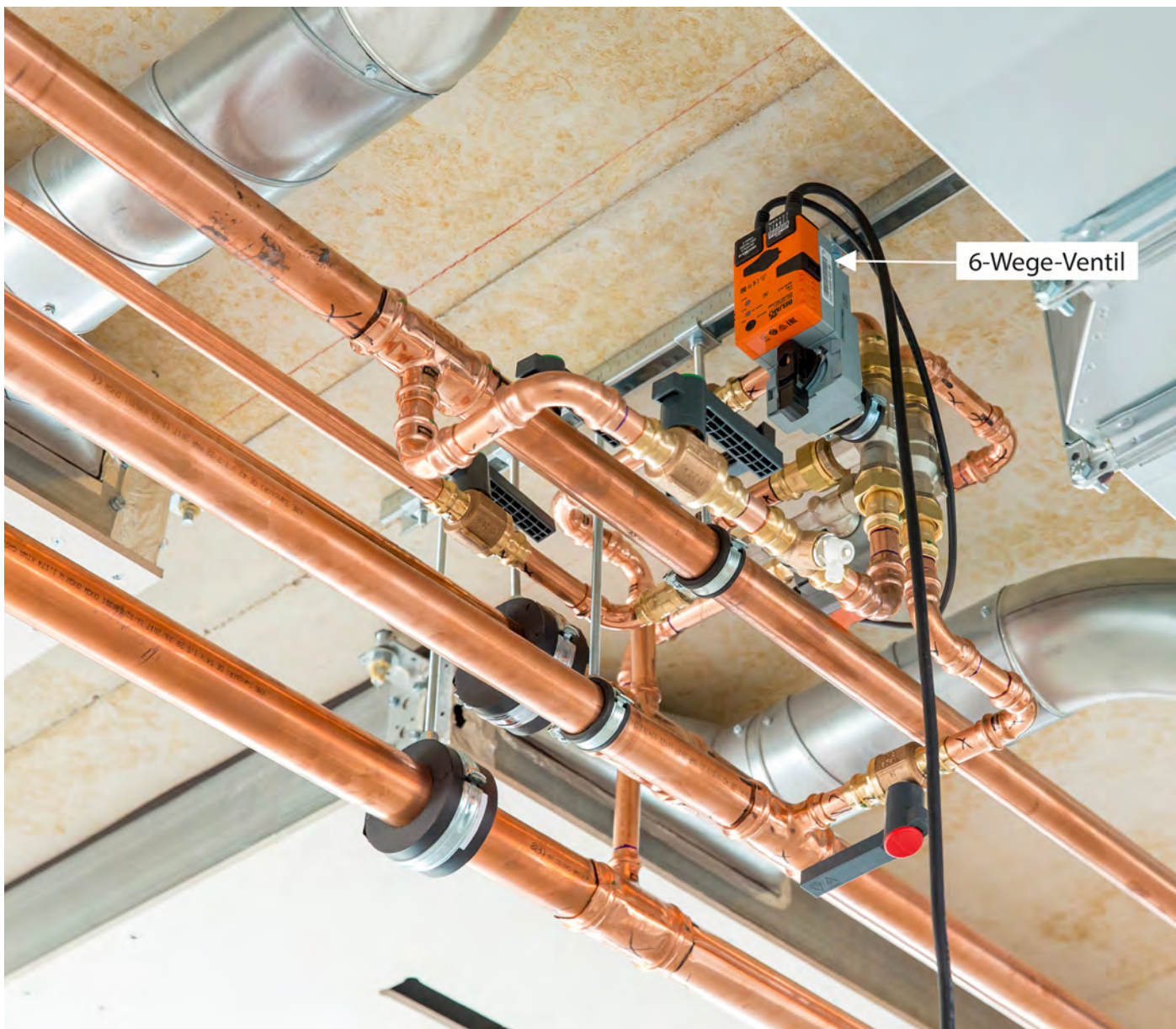
Das Belimo 6-Wege-Ventil zur Verteilung von Wärme und Kälte
